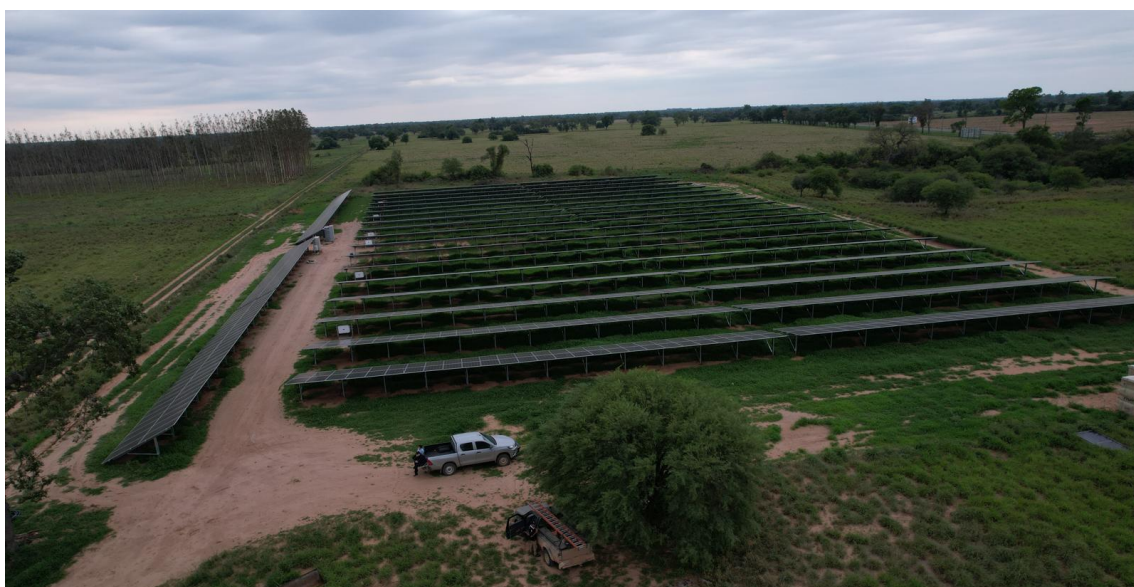
IMAGEN AÉREA DE LAS INSTALACIONES
