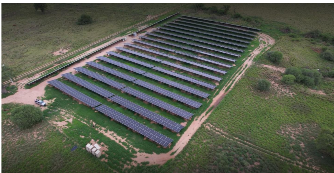
IMAGEN AÉREA DE LAS INSTALACIONES
