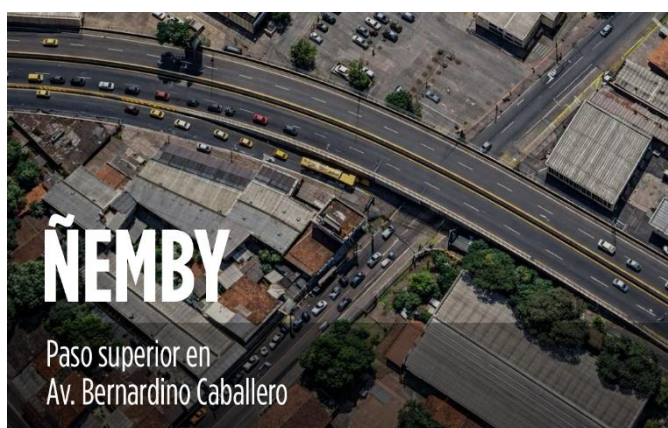
Figura N° 6. Paso Superior Avda. Bernardino Caballero Fuente: MOPC
