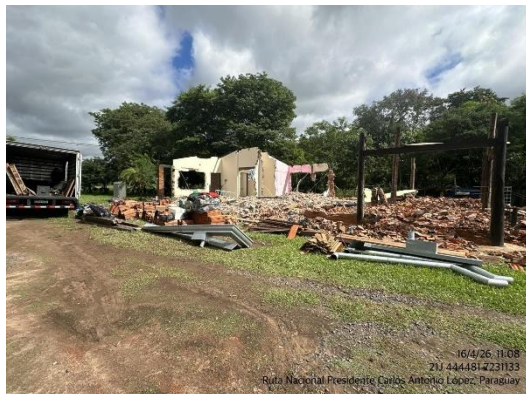
Fotografía 1. Área en donde se localizará el proyecto
