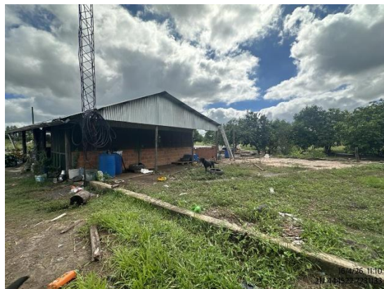
Fotografía 4. Área en donde se localizará el proyecto
