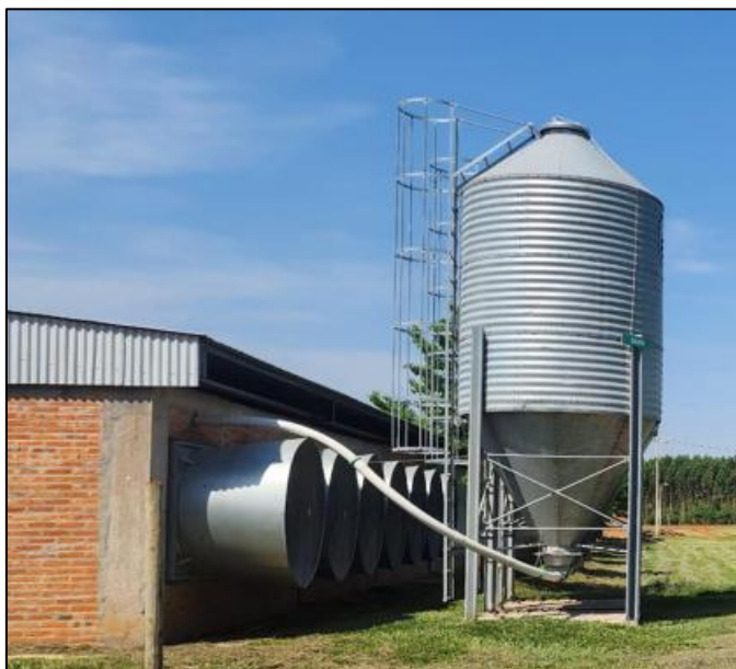
Figura 17 Proyecto aviario – Silo
