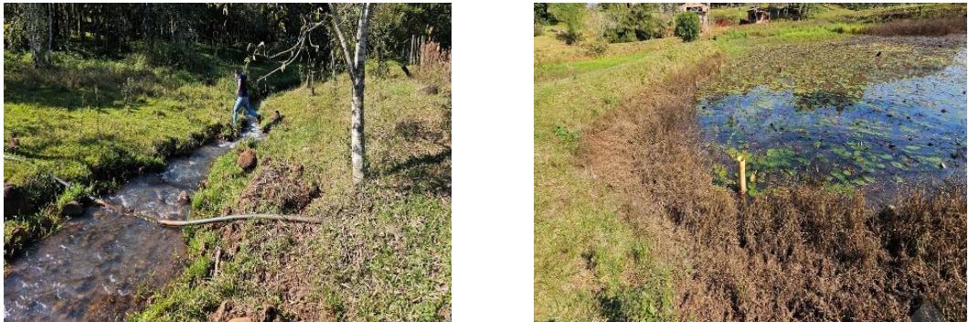
Imagen N° 02: Caños subterráneos que permiten la circulación del agua.
