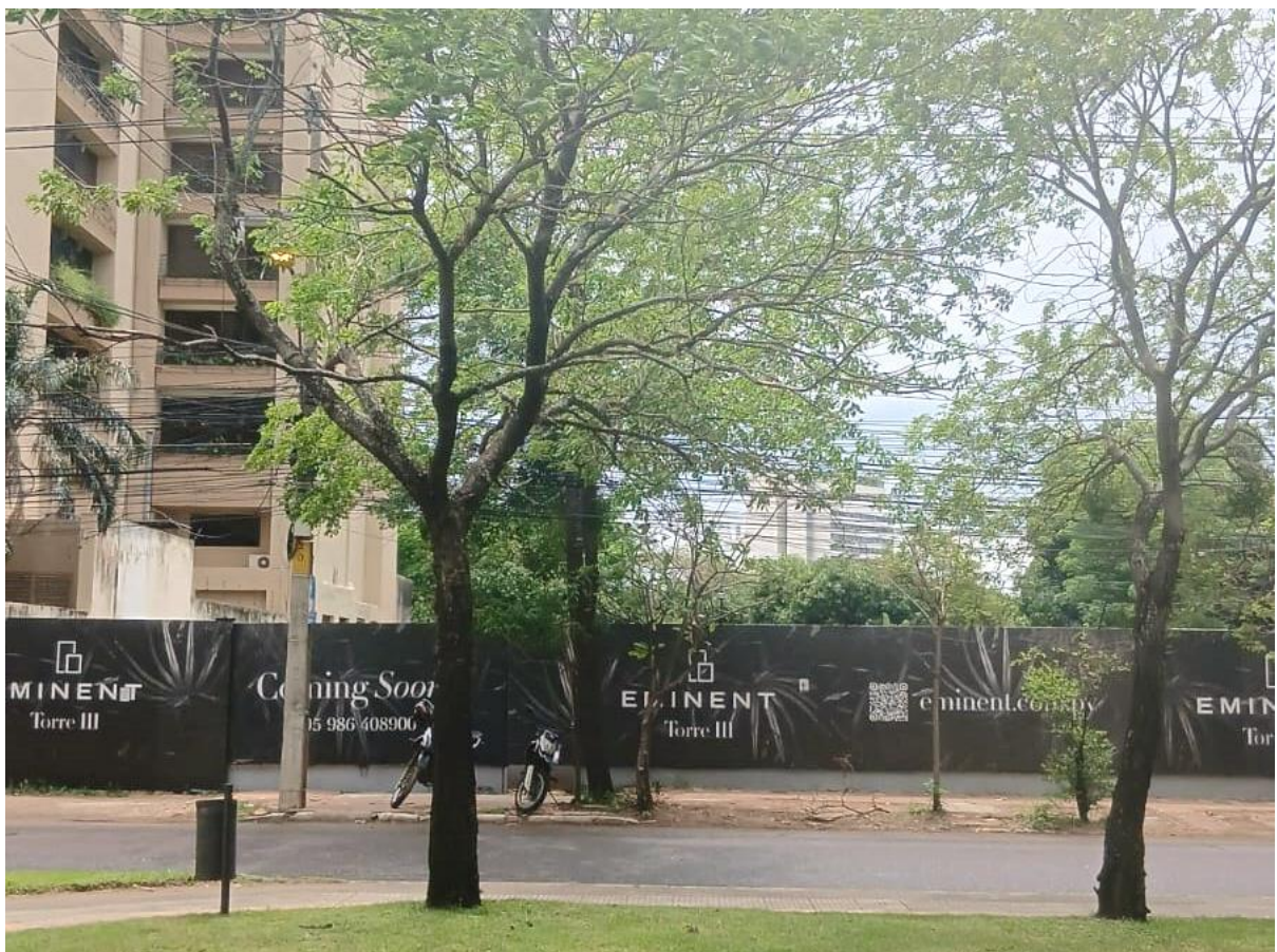
Vista del inmueble del proyecto
