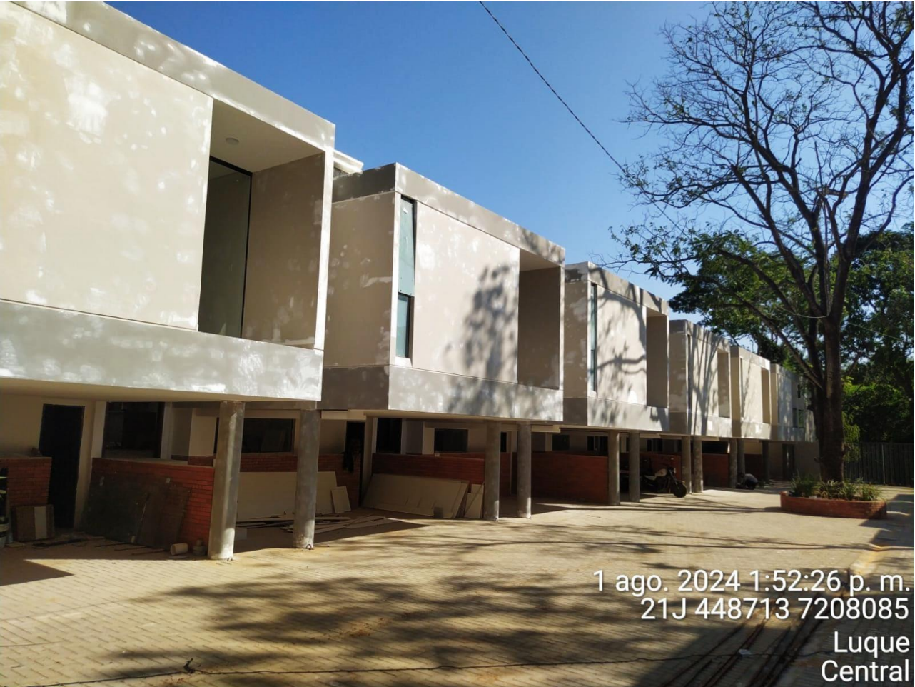
Vista del inmueble a intervenir
