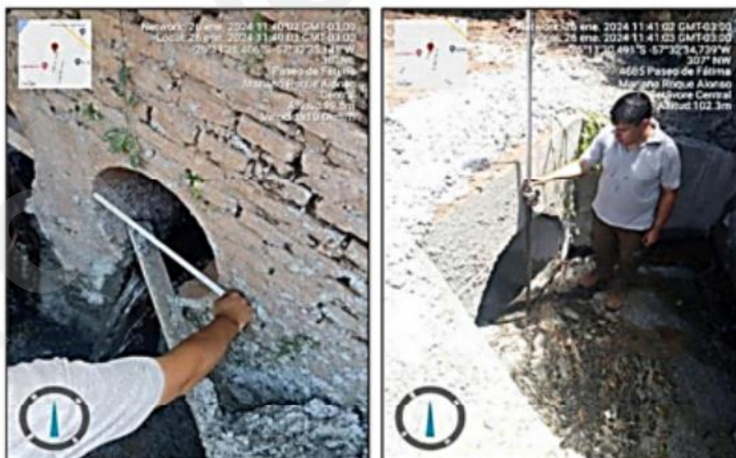
Ilustración 17: Registro 01. Inicio de entubamiento.
