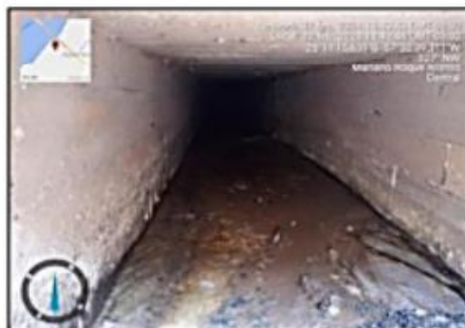
Ilustración 10: Galería Receptora del entubamiento construido en el Centro Logístico La Paz
