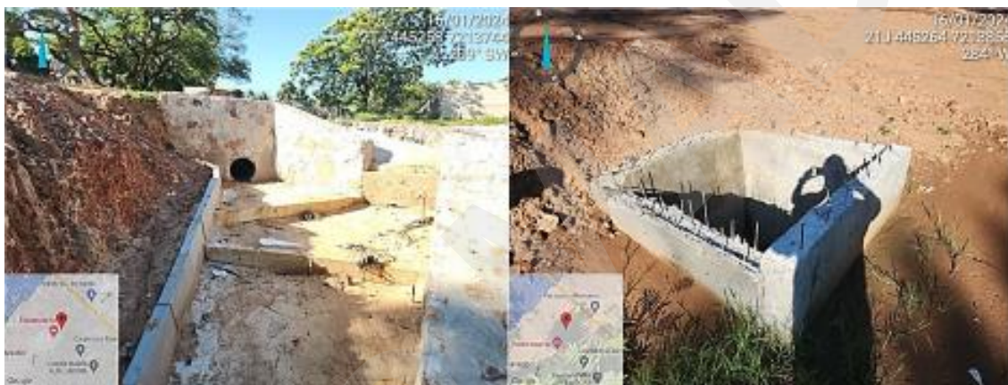
Fotografías 4. Canal a cielo abierto con muro de protección de Hº Aº con mampostería de piedra bruta y caja de mantenimiento de la canalización y entubado al cauce hídrico existente.
