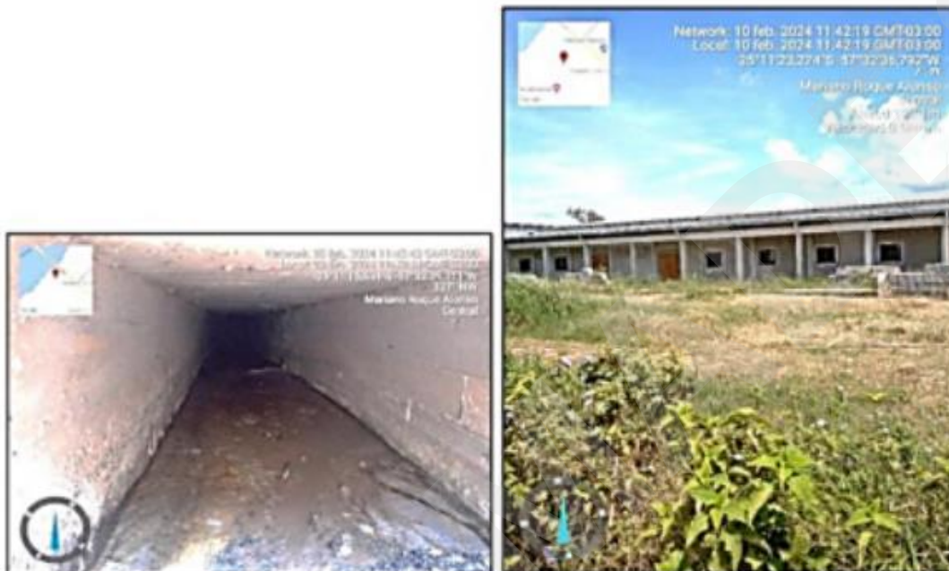
Ilustración 22: Vista interior de la galería de descarga y edificación en el predio militar.
