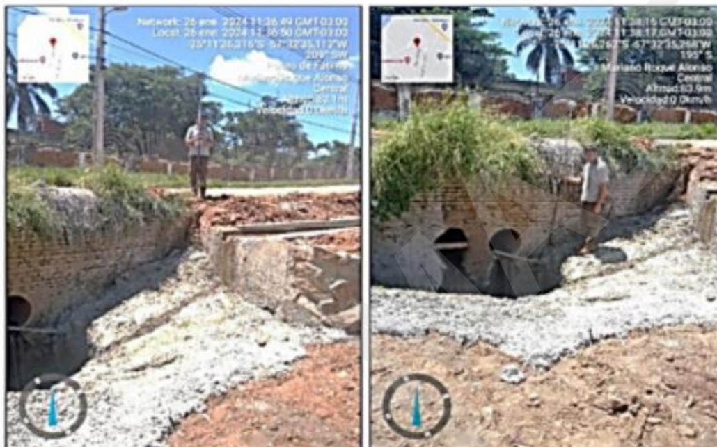
Ilustración 16: Registro 01. Inicio de entubamiento.
