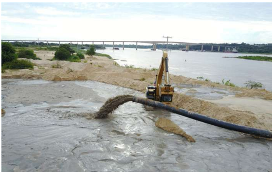
Imagen 54. Ejemplo de sujeción a una retroexcavadora (foto archivo)
