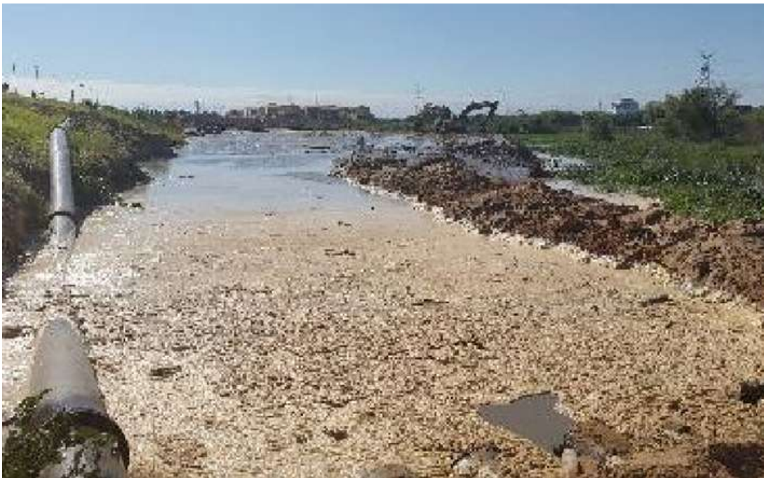
Imagen 17. Ejemplo de Salida del lavado del proceso de refulado por vertedero. (foto archivo)
