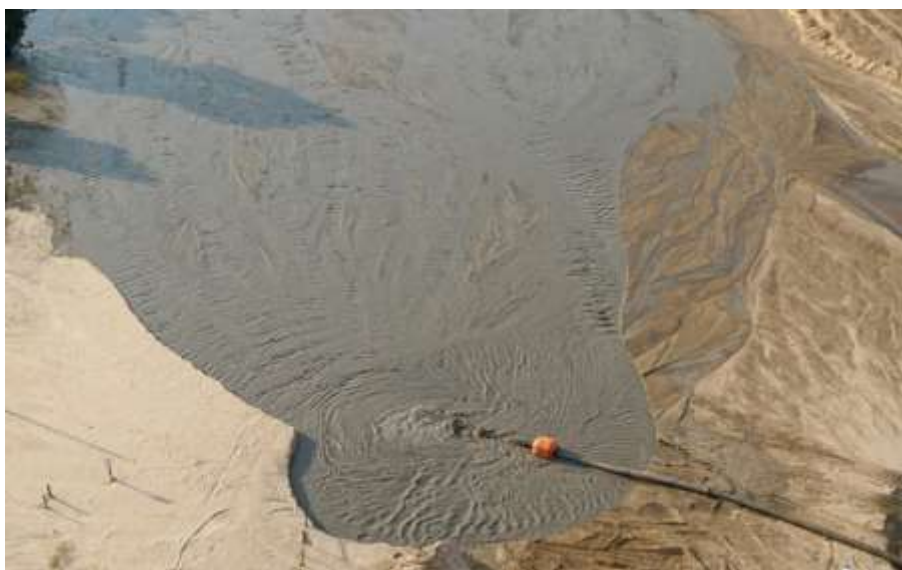
Imagen 92. Ejemplo de Sistema de descarga (foto archivo)
