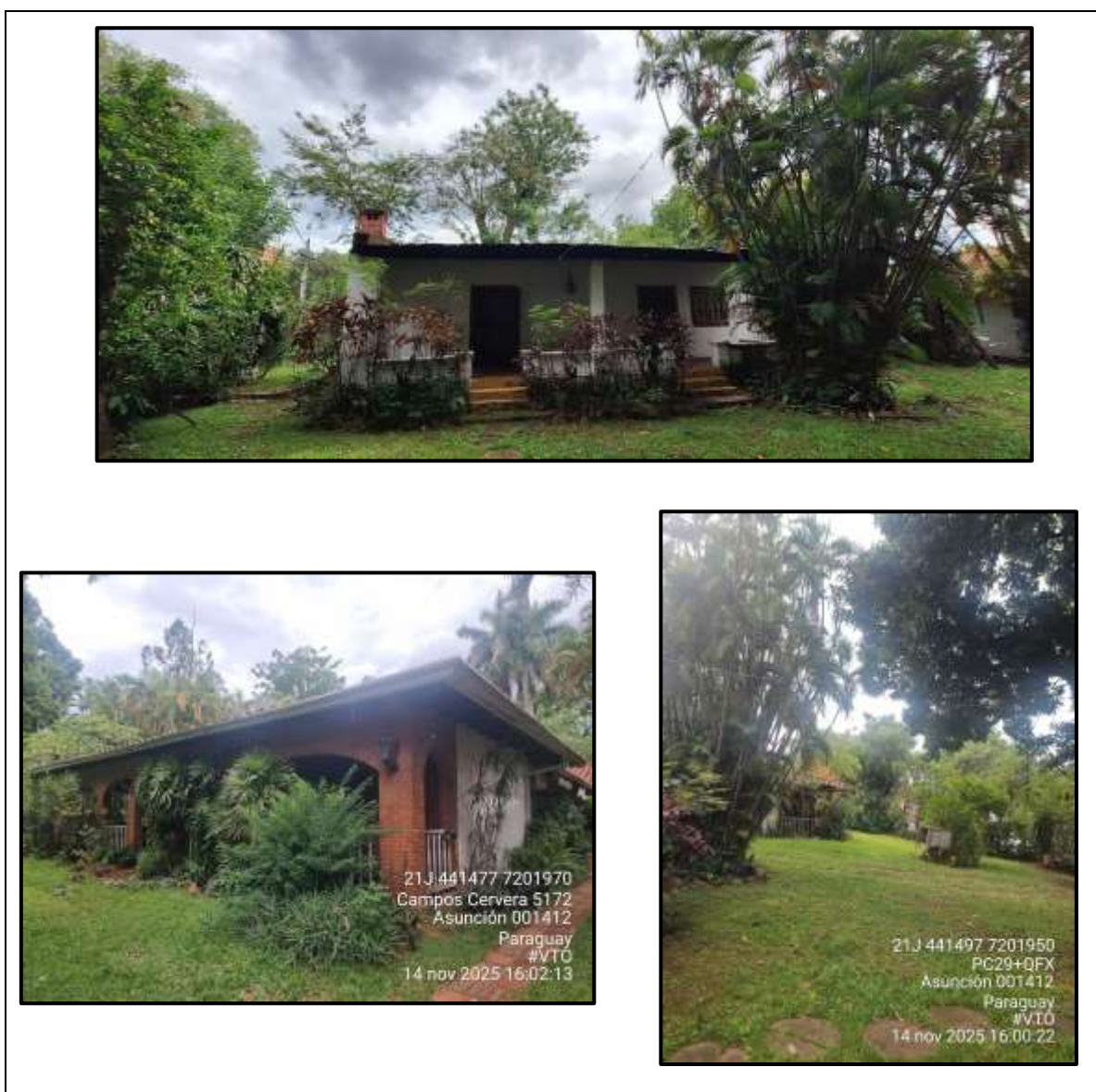
Fotografía: 2: Vista General del predio
