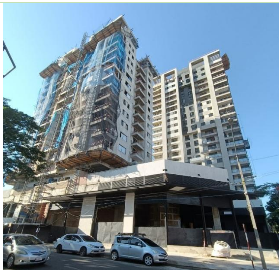
Sobre la calle Dr. Eulogio Estigarribia entre Cruz del Chaco y Charles de Gaulle, se encuentra en construcción el complejo More Mariscal.
