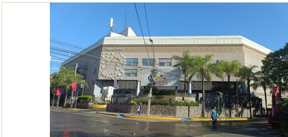
Las instalaciones del Shopping Mariscal (bloque 1) ubicado entre Dr. Eulogio Estigarribia y Charles de Gaulle.
