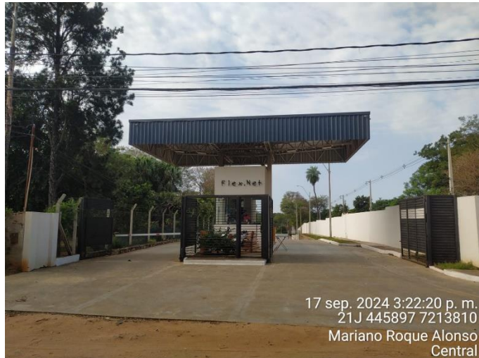
Vista del acceso del parque logístico
