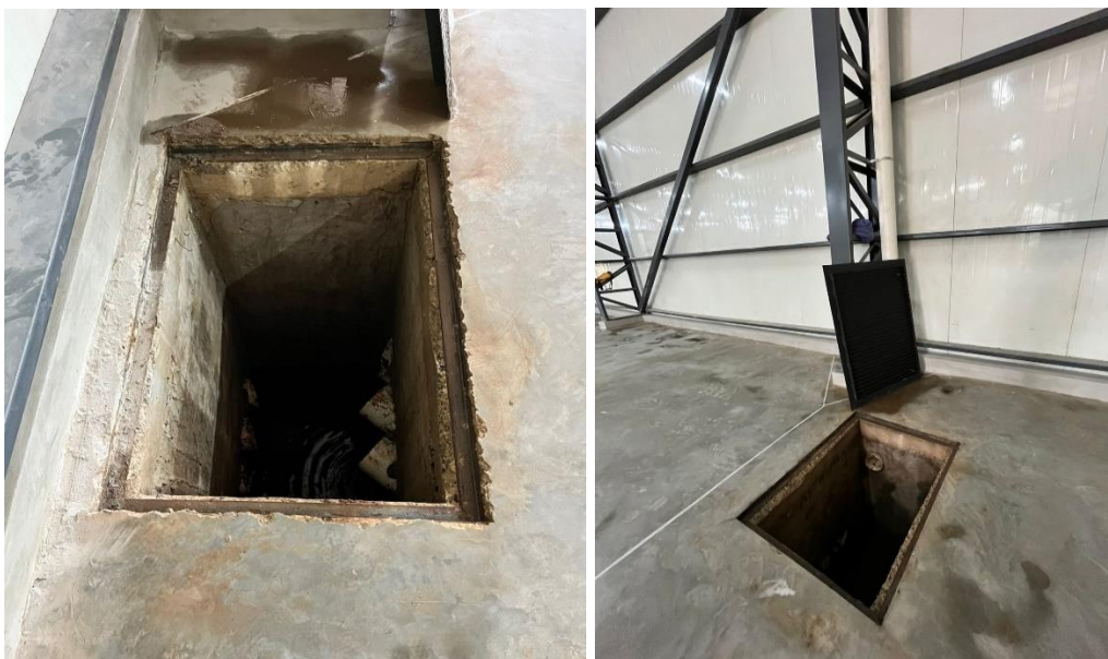
Vista del desagüe pluvial interno
