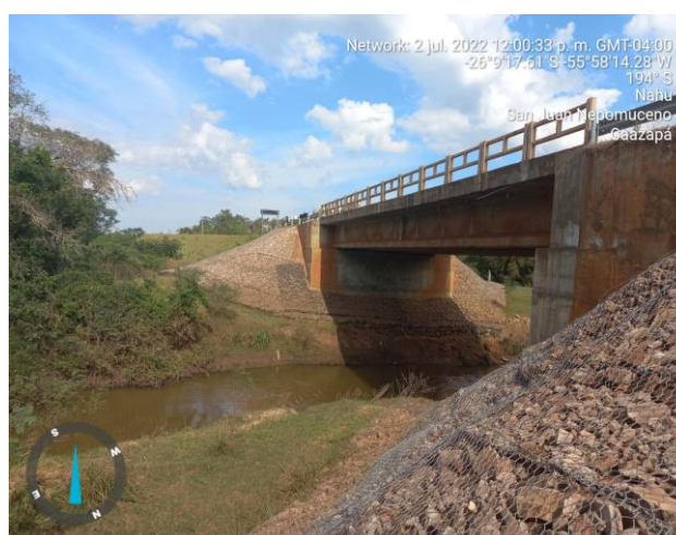
Fotografía N°5. Gaviones de protección del talud en caso de desbordes.
