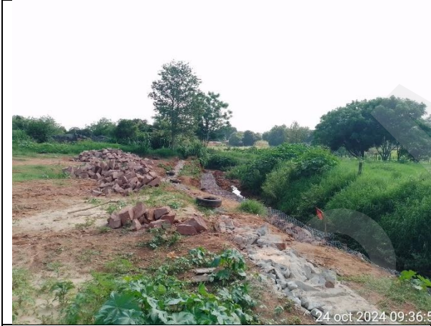
Construcción de gaviones de piedras con mallas metálicas.
