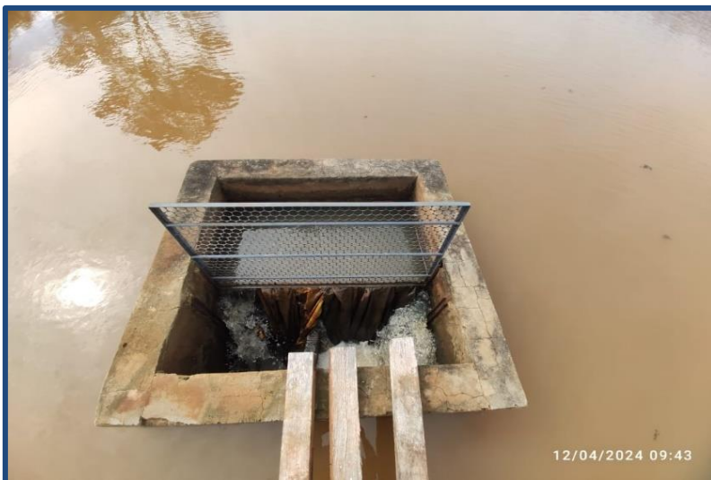
Desagüe del estanque 2.
