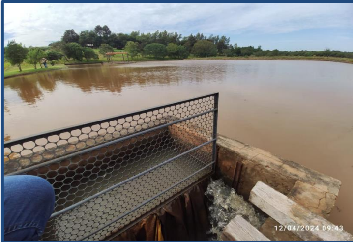
Desagüe del estanque 2
