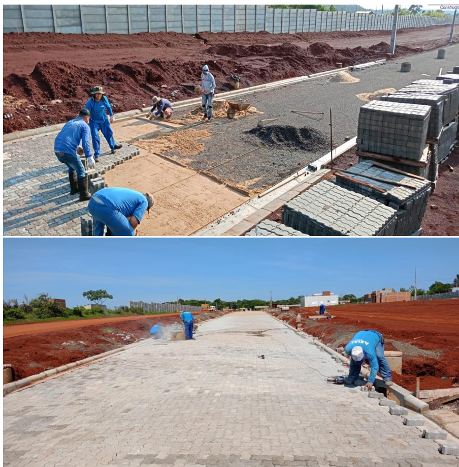
Imagen ilustrativa 3: colocación de pavimento intertrabado
