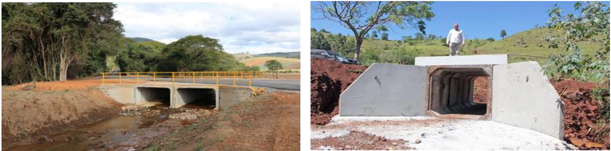
Imagen ilustrativa 5: puente con alcantarilla celular
