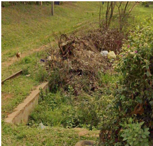
Figura N° 18. PK 25+550 Residuos en zona de dominio de las vías férreas.
