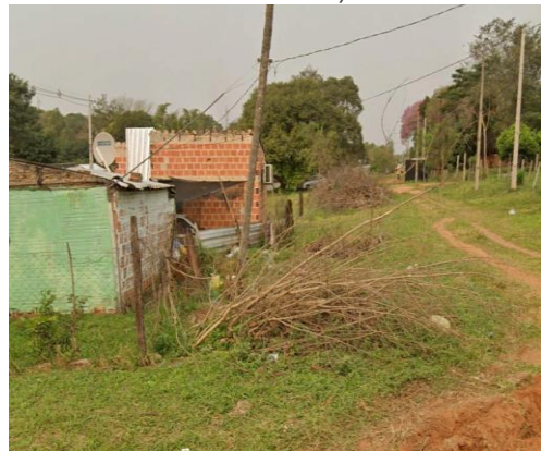
Figura N° 17. PK 25+800 Viviendas ubicadas en la zona de dominio de las vías férreas.
