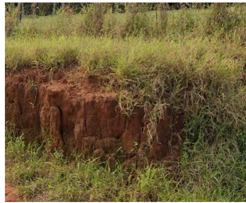
Figura N° 23. Pk(0+100) Suelo erosionado.
