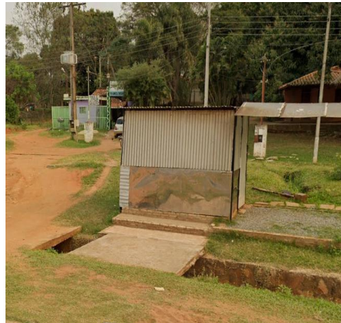
Figura N° 19. Pk 34+700. Se localizan puestos comerciales en zona de dominio de las vías férreas.
