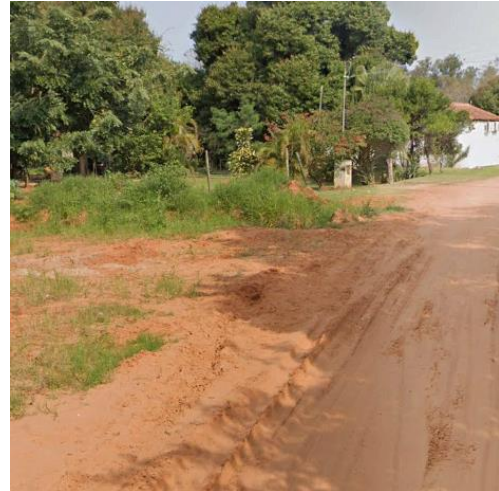
Figura N° 21. Pk 22+550 Suelo erosionado
