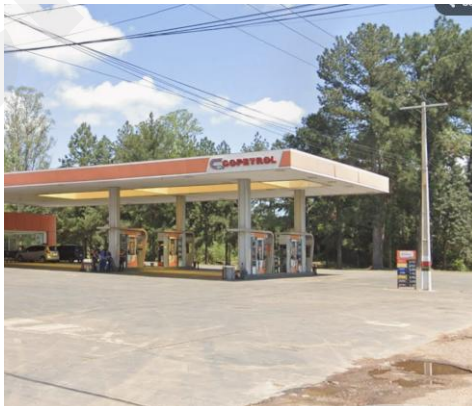
Figura N° 17. PK 10+100 Incertidumbre en las condiciones de suelo.
