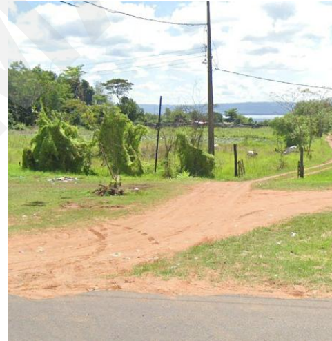
Figura N° 16. PK 10+900 Incertidumbre de las condiciones de las vías férreas y erosión del suelo.
