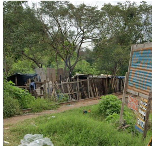
Figura N° 22. Ocupación informal de franjas de dominio del ferrocarril (Pk 28+400).
