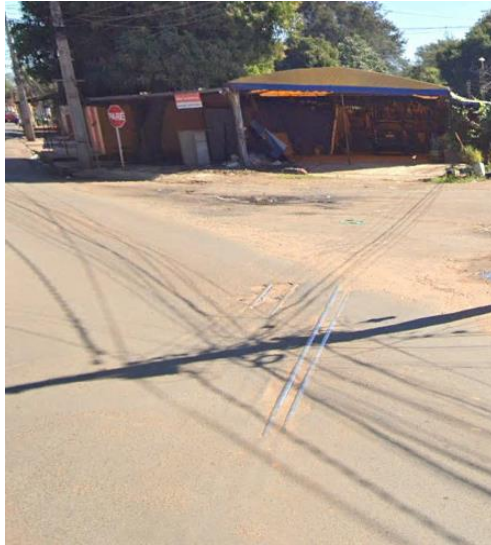
Figura N° 25. Incertidumbre sobre la localización y condición de las vías férreas en zonas donde el pavimento u otros materiales las cubren (Pk 28+900).
