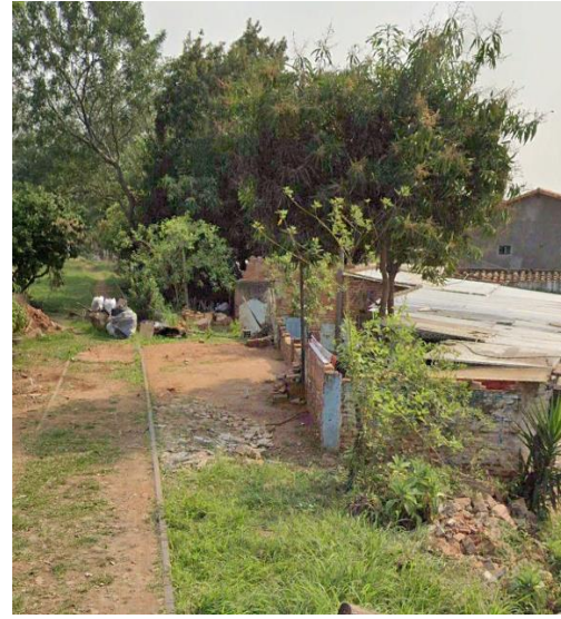
Figura N° 20. Ocupación informal de franjas de dominio del ferrocarril (Pk 30+250).
