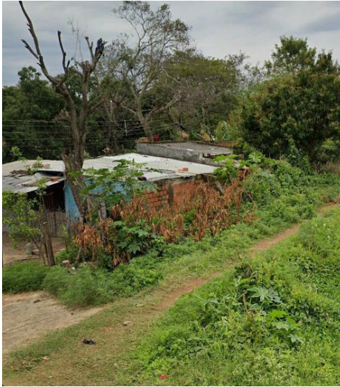
Figura N° 19. Ocupación informal de franjas de dominio del ferrocarril (Pk 28+850).
