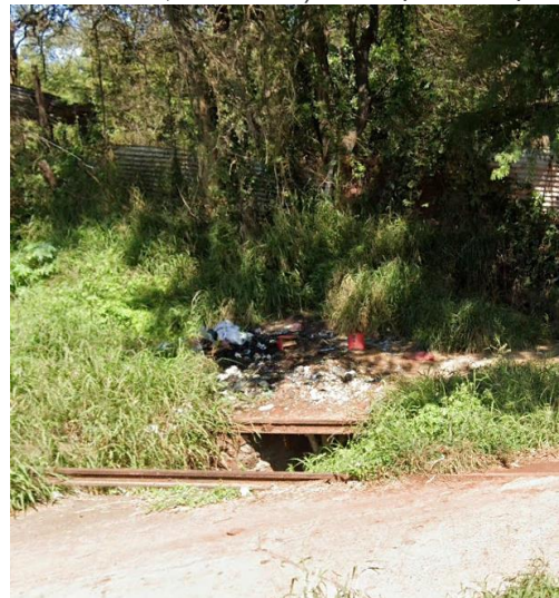
Figura N° 18. Vertederos de basura a cielo abierto (Pk 28+950).
