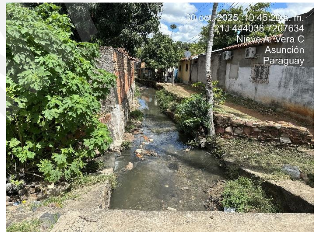
Foto 4: Recorrido de cauce pluvial con aguas cloacales
