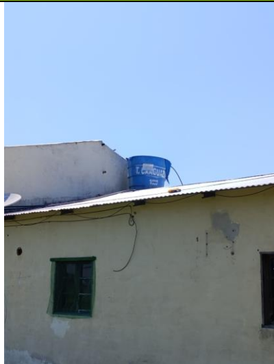
A8. Tanque de agua
