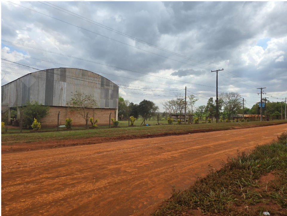
Imagen 1. Vista general de la propiedad
