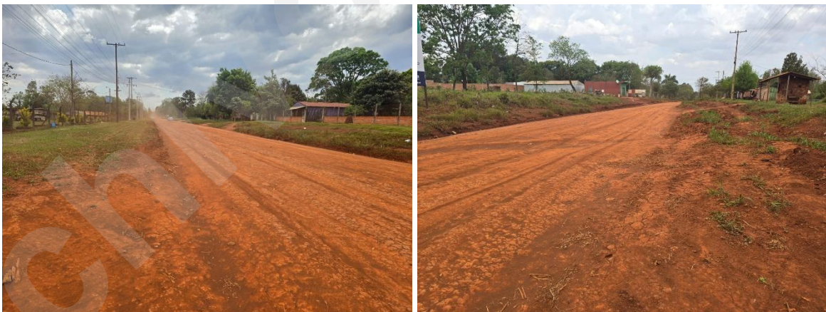
Vista del emplazamiento
