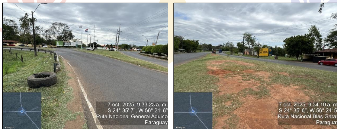
Disposición informal de residuos sólidos
