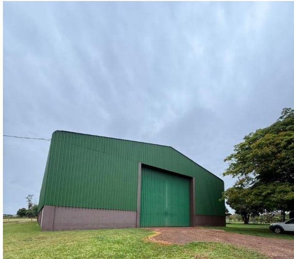
IMAGEN 9. Fotografía, Deposito de maquinarias y herramientas.
