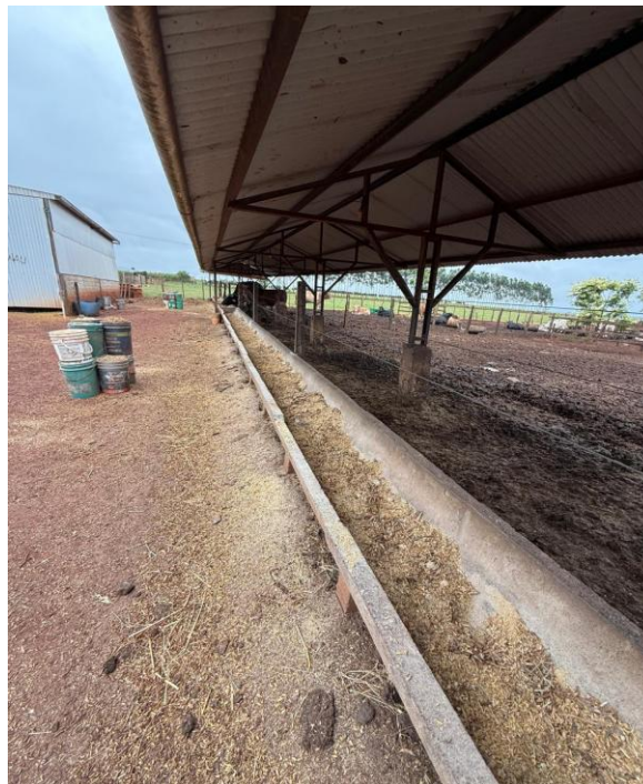
IMAGEN 10. Fotografía- Infraestructura/área de alimentación
