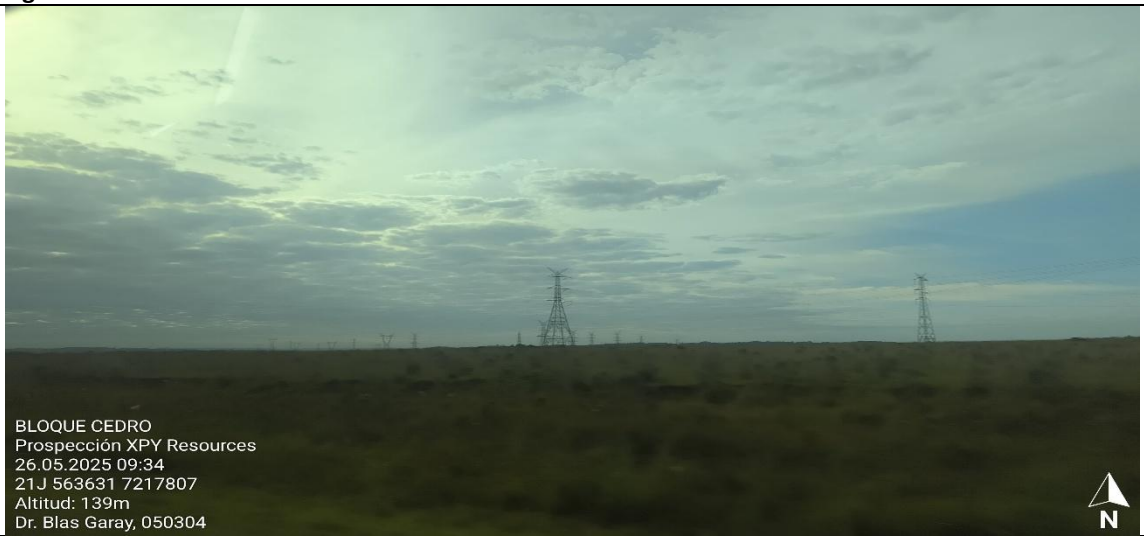
Fotografía 4. Líneas de transmisión eléctrica
