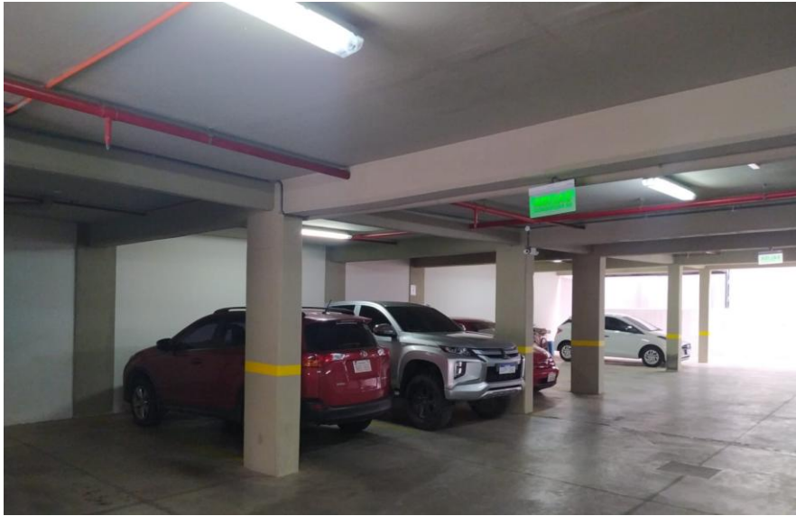
Vista del estacionamiento interno del edificio de departamentos
