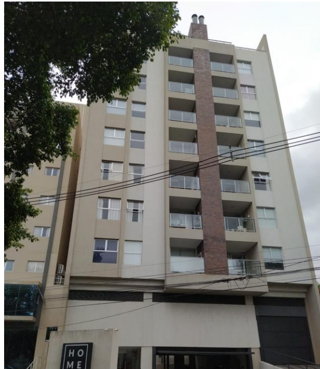
Vista de la fachada del edificio de departamentos.
