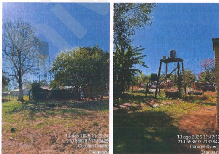
Ilustración 20. Izquierda: M.S.P y B.S. Tanque de agua de la Junta de Saneamiento Calle Jhovy. Derecha: tanque de agua en la propiedad.
