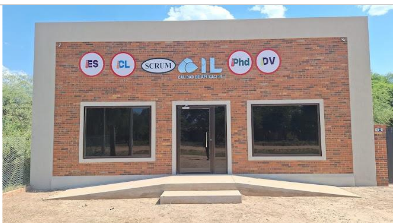
Fachada del Deposito
