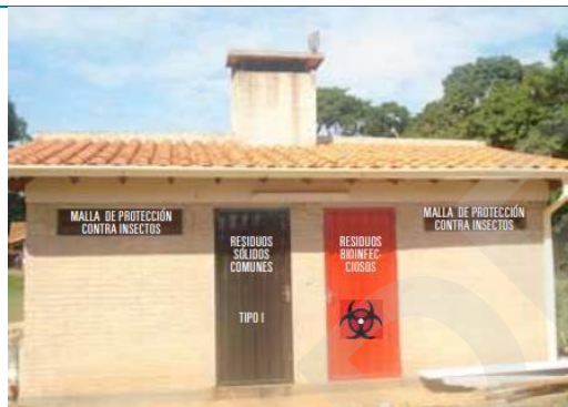
Figura 13: Infraestructura para el almacenamiento temporal de residuos hospitalarios
