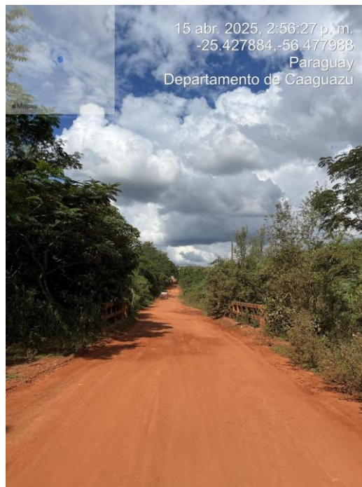
Figura 8. Estado el camino, se encuentran tendidos eléctricos y alambradas
