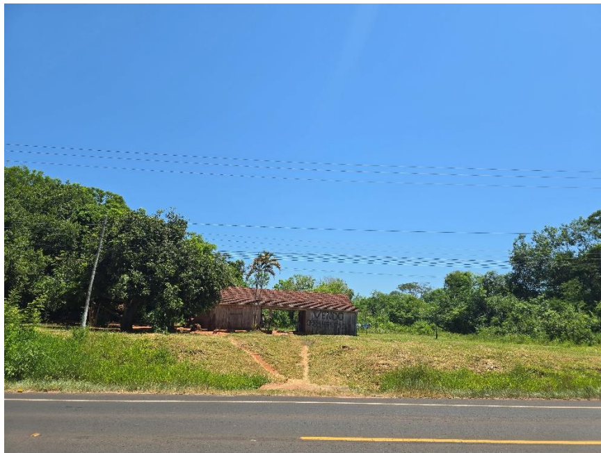
Vista del inmueble a ser intervenido.
