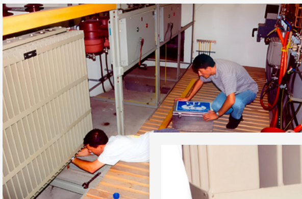
Figura 23: Ubicar la bandeja de goteo debajo de la llave de drenaje
