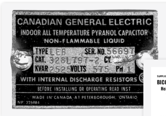
Figura 10: Identificación del fluido del capacitor
