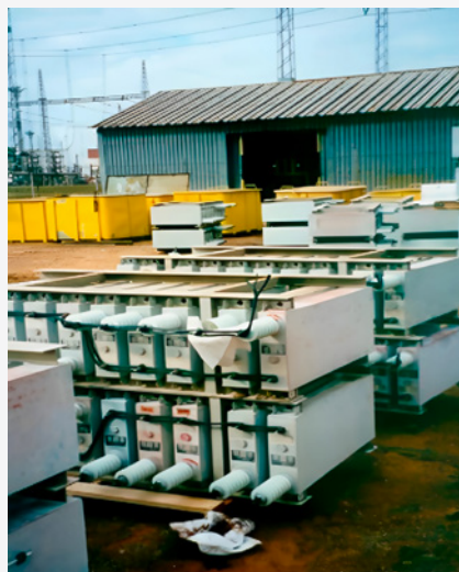
Figura 55: Retiro de circulación de la batería de un capacitor
