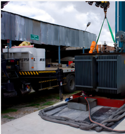
Figura 52: Drenaje de un transformador con PCB
