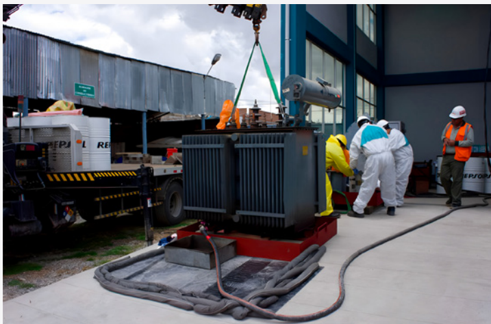
Figura 54: Cercado en el área de trabajo
