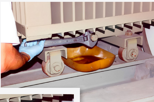
Figura 23: Ubicar la bandeja de goteo debajo de la llave de drenaje
