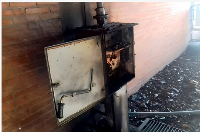
Figura 100: Equipo de maniobra de 66,000 voltios que se averió
