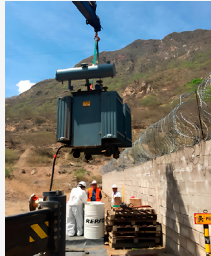
Figura 52: Drenaje de un transformador con PCB
