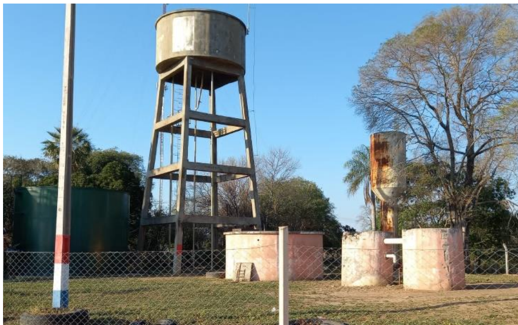
Figura N° 16. Junta de Saneamiento local.
