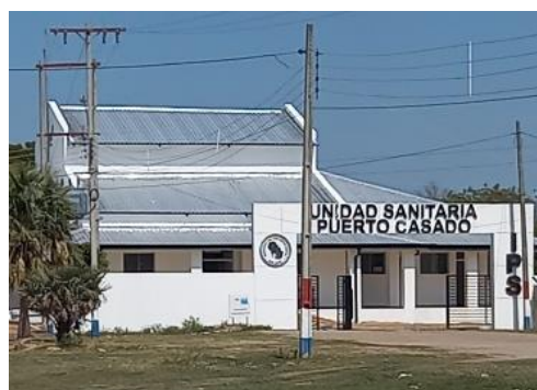
Figura N° 26. Unidad Sanitaria IPS.
