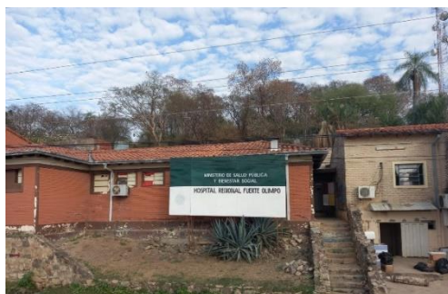
Figura N° 19. Hospital Distrital Fuerte Olimpo.
