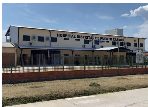
Figura N° 25. Hospital Distrital de Puerto Casado.
