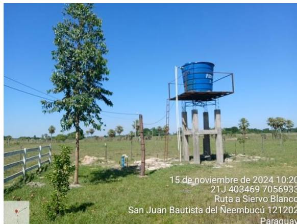
Vista del pozo tubular profundo y tanque de almacenamiento de agua.
