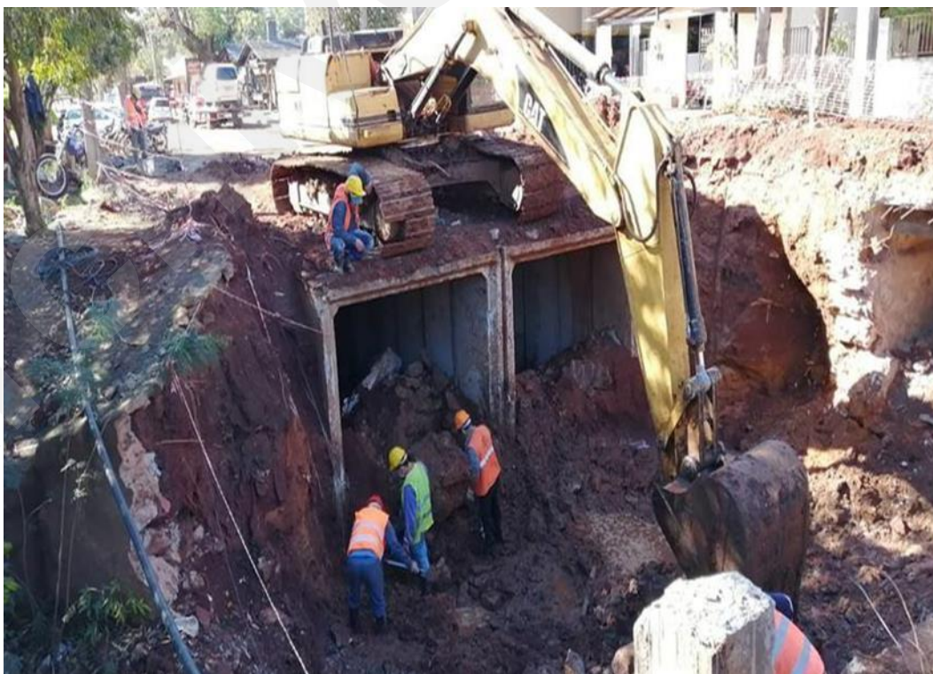
Imagen referencial de la construcción de galerías de drenaje pluvial en la ciudad de Asunción
