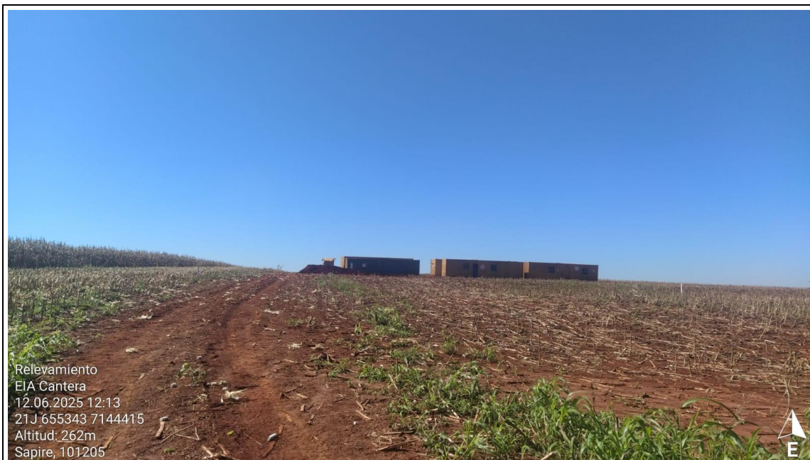
Evidencia fotográfica N° 3. Área de equipos
