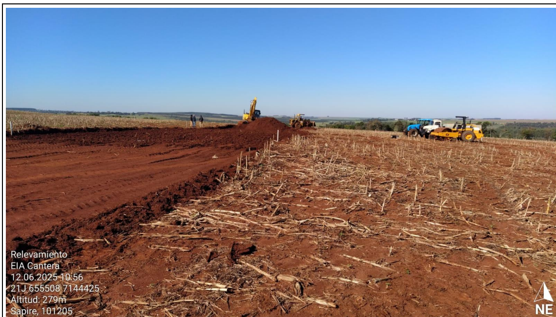
Evidencias fotográficas N° 1. Trabajos iniciales de preparación del suelo
