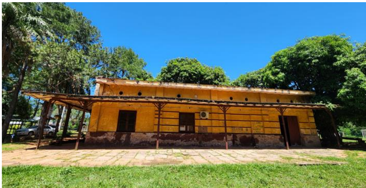
Figura 32 FACHADA PRINCIPAL. Estación Patiño
