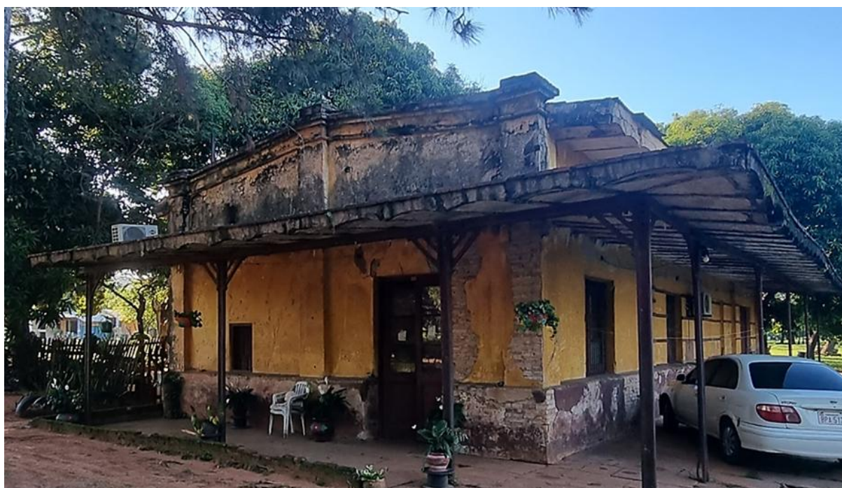
Figura 33 Costado de la Estación, donde se observa su estado de conservación y uso actual (2023)
