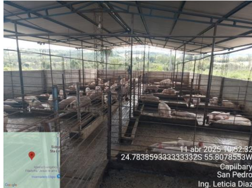
Evidencia fotográfica N° 1 Galpón de engorde porcino.
