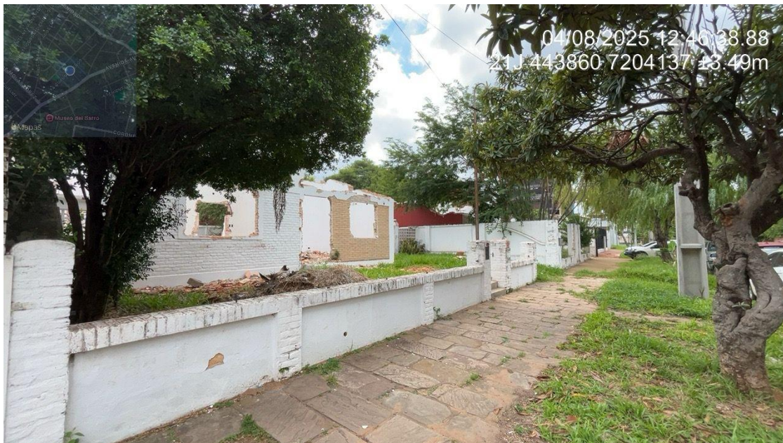
Vista frontal del inmueble a intervenir
