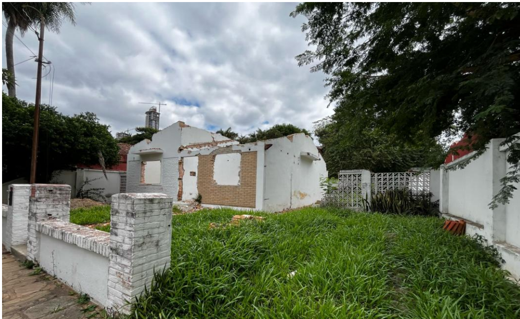
Vista del inmueble a intervenir, se aprecia construcciones anteriores a demoler
