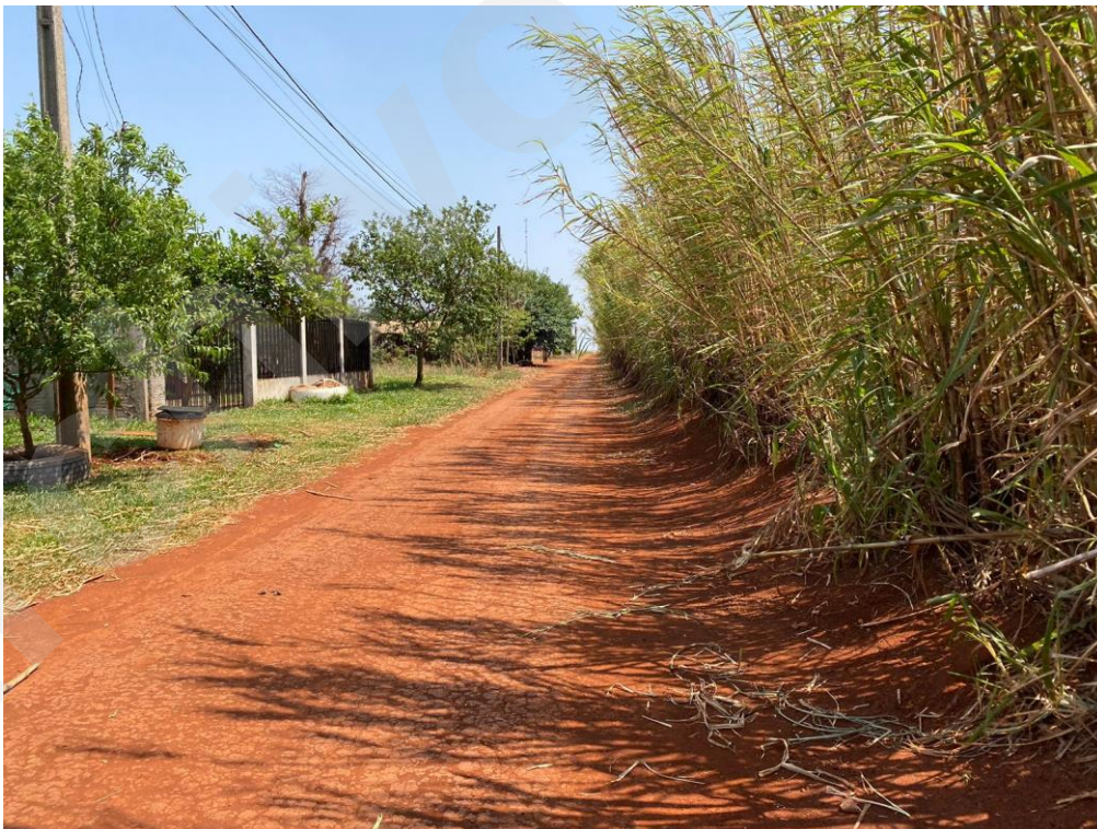
Imagen 09: caminos vecinales al costado del lado Este del inmueble de 8 m. esta será ensanchada a 16 metros con empedrado.
