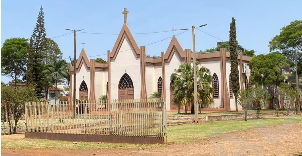
Imagen 01: Iglesia a unos 200 metros del proyecto.
