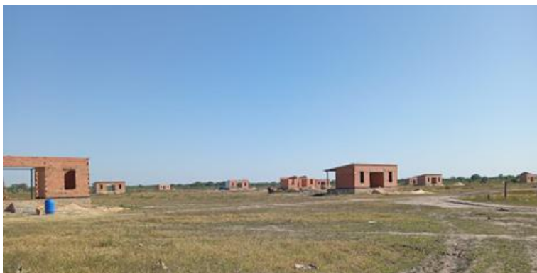
Figura 37. Viviendas en construcción
