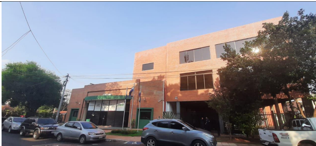
Foto 1: Las oficinas del CONACYT se encuentra sobre la calle Justo Prieto, proximo a las instalaciones del Colegio del Sol.
