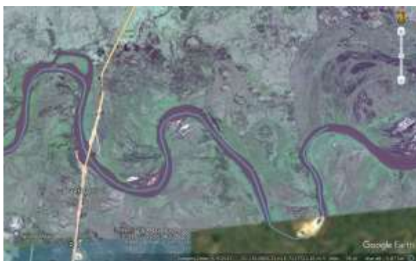
Figura 4a: Río Jejuy en 2013. El 100 % del caudal del río en aguas bajas circula por el puente principal.
