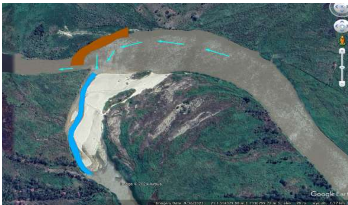
Figura 5: canalización a través de sedimento depositado (azul) y zona de disposición de material extraído (marrón).
