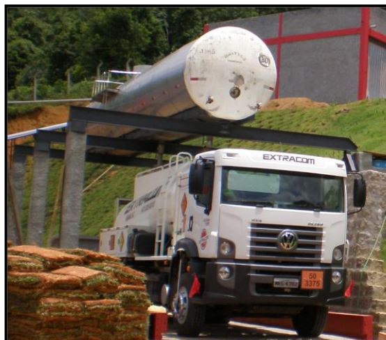
Foto N° 13: Camión Cisterna en Proceso de Carga- Demostrativo
