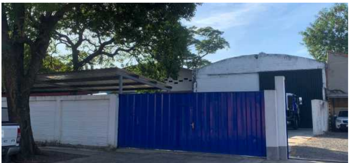
Figura 1. Fotografía panorámica de la fachada actual del predio del proyecto “Unidad de Tableros Eléctricos y Afines”. Fuente: Elaboración propia.
