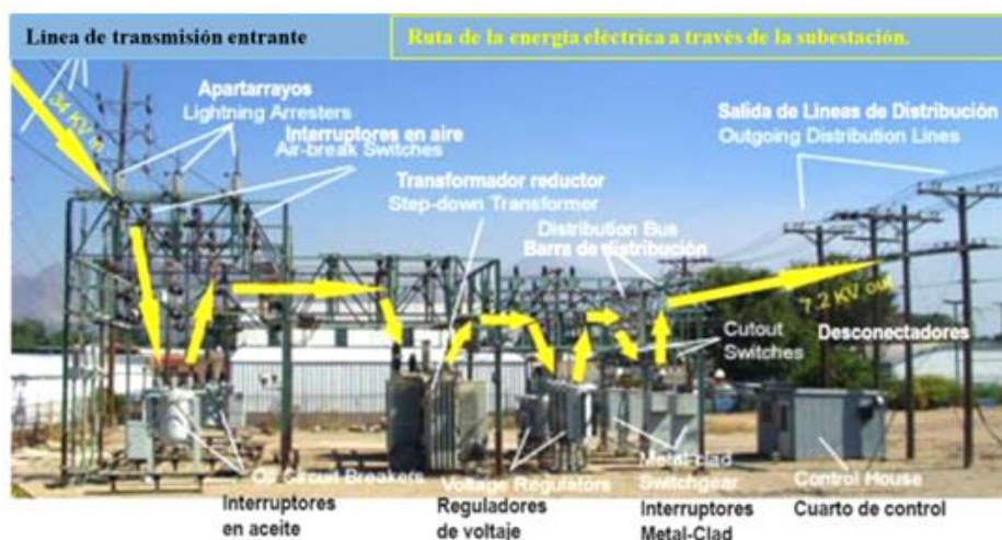
Ilustración N° 20 – Disposición de componentes de Subestación reductora
