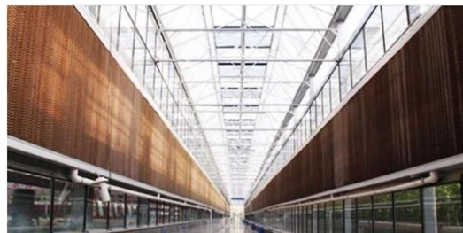
Ilustración N° 44 – Esquema de funcionamiento del DEC y Vista de los filtros húmedos o almohadillas de DEC instalados.
