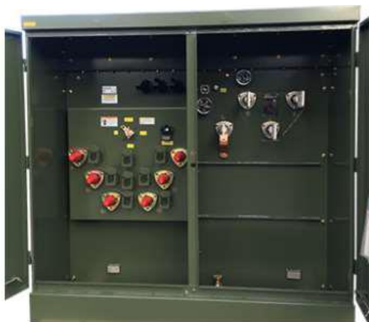
Ilustración N° 47 – Transformador de Pedestal para conexión en Anillo (loop)
