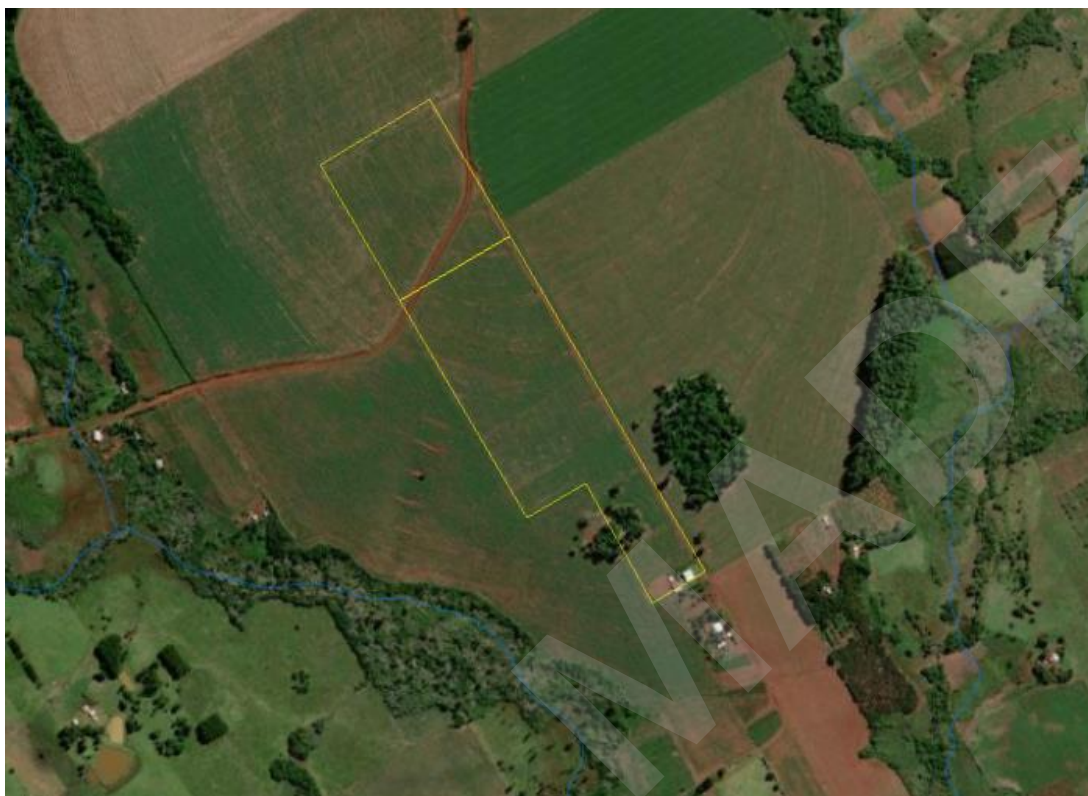
Ilustración 5 Zona de cruce del cauce.
