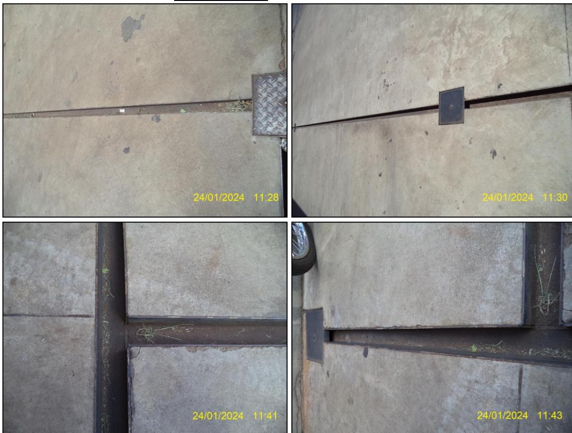
Fotos N° 5 al 8: Canaleta Perimetral
